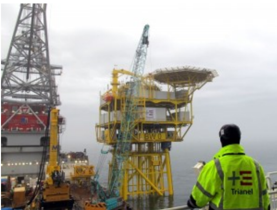
Bau der Umspannplattform
