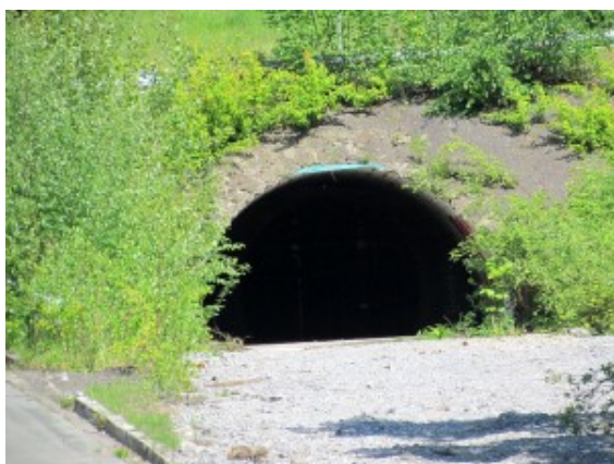
Der Eingang zu Tunnel in
