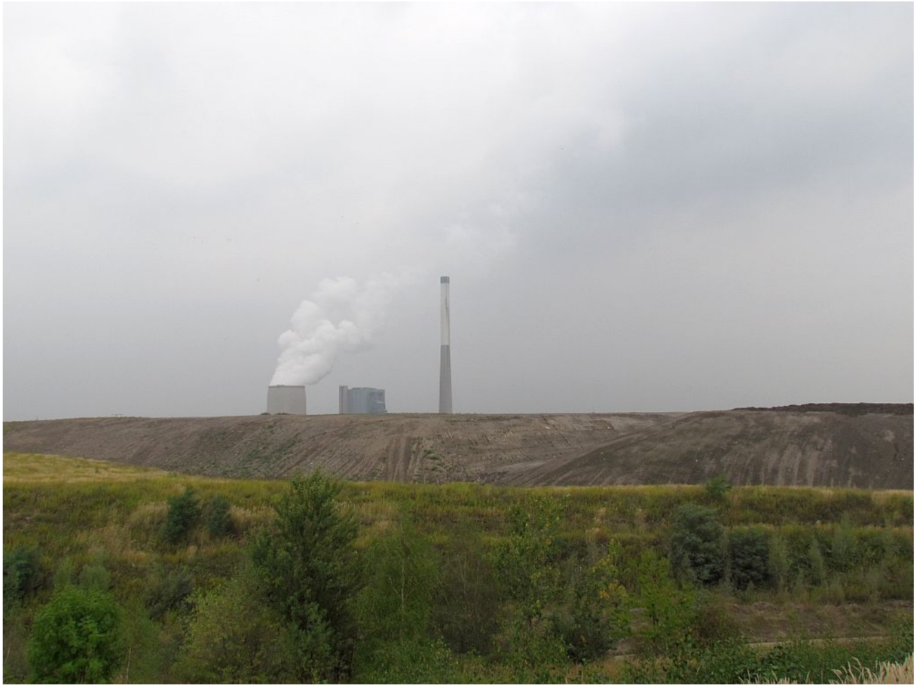
Haldenpanorama mit Kraftwerk
