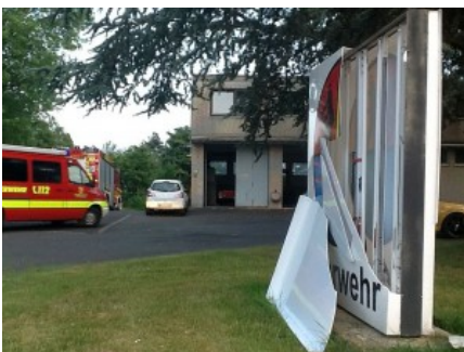
Die Zerstörung des
