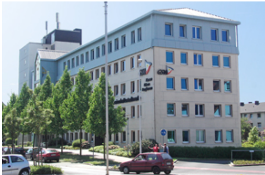
GSW-Gebäude in Kamen.
