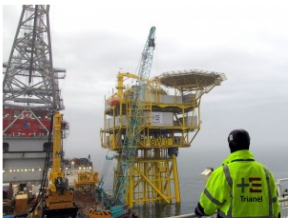
Bau der Umspannplattform
