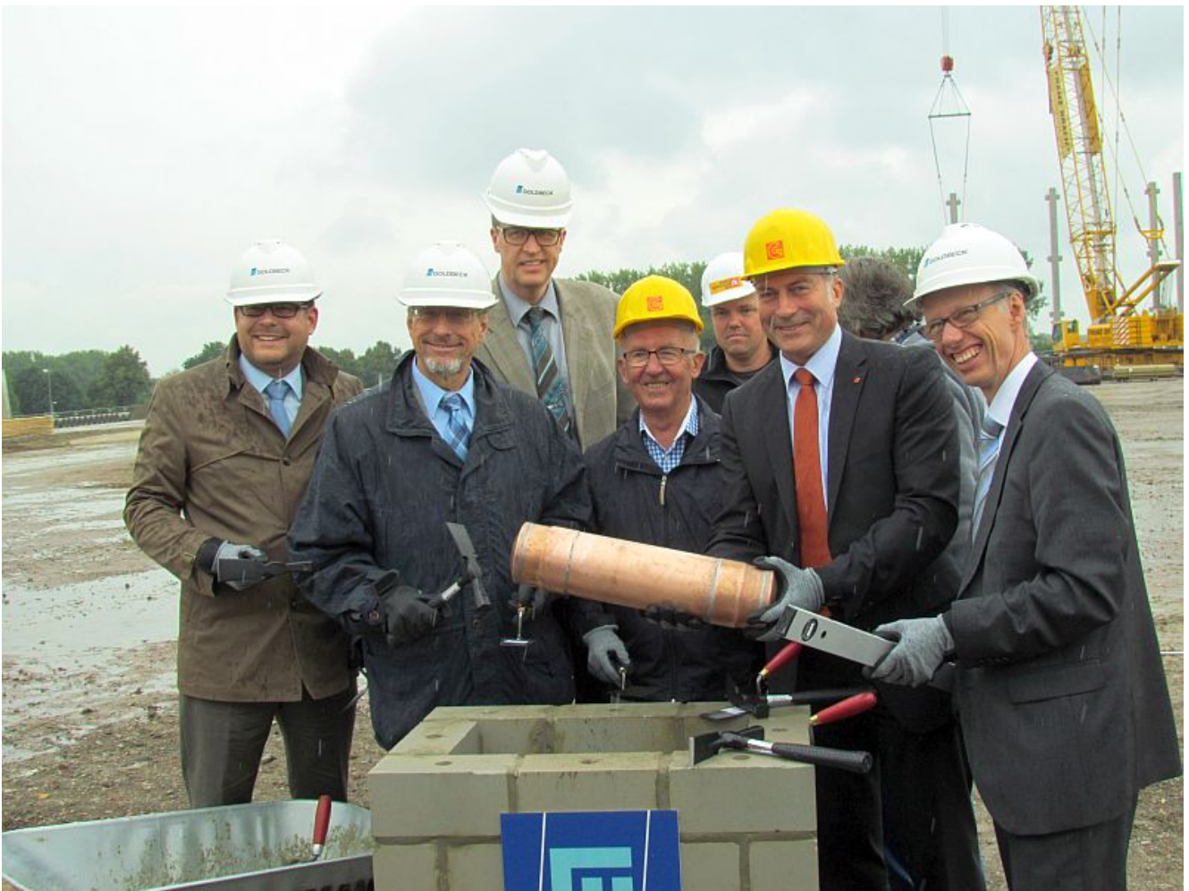
Erste Grundsteinlegung im Logistikpark A 2.
