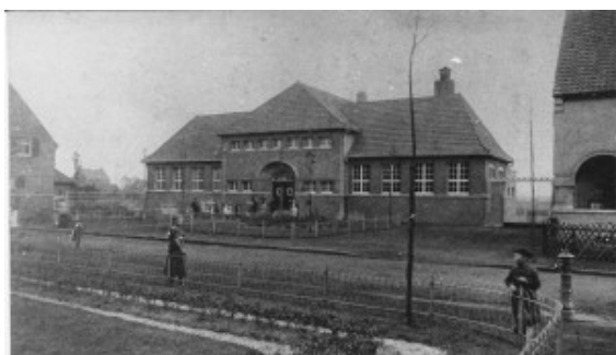
Ehemaliges Wohlfahrtsgebäude in der
