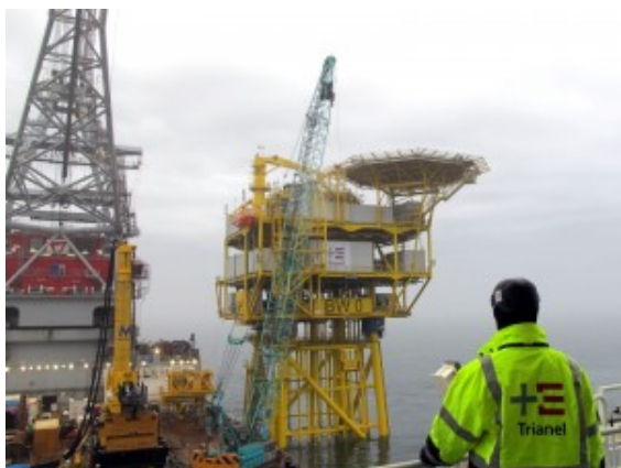
Bau der Umspannplattform
