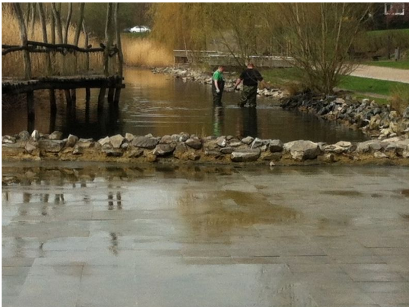
Reinigungsarbeiten im Teich im Wasserpark
