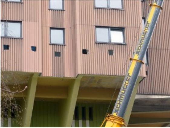
Deutlich sind die Löcher zu erkennen, in die die Stahlträger für das Gerüst hineingesteckt werden.
