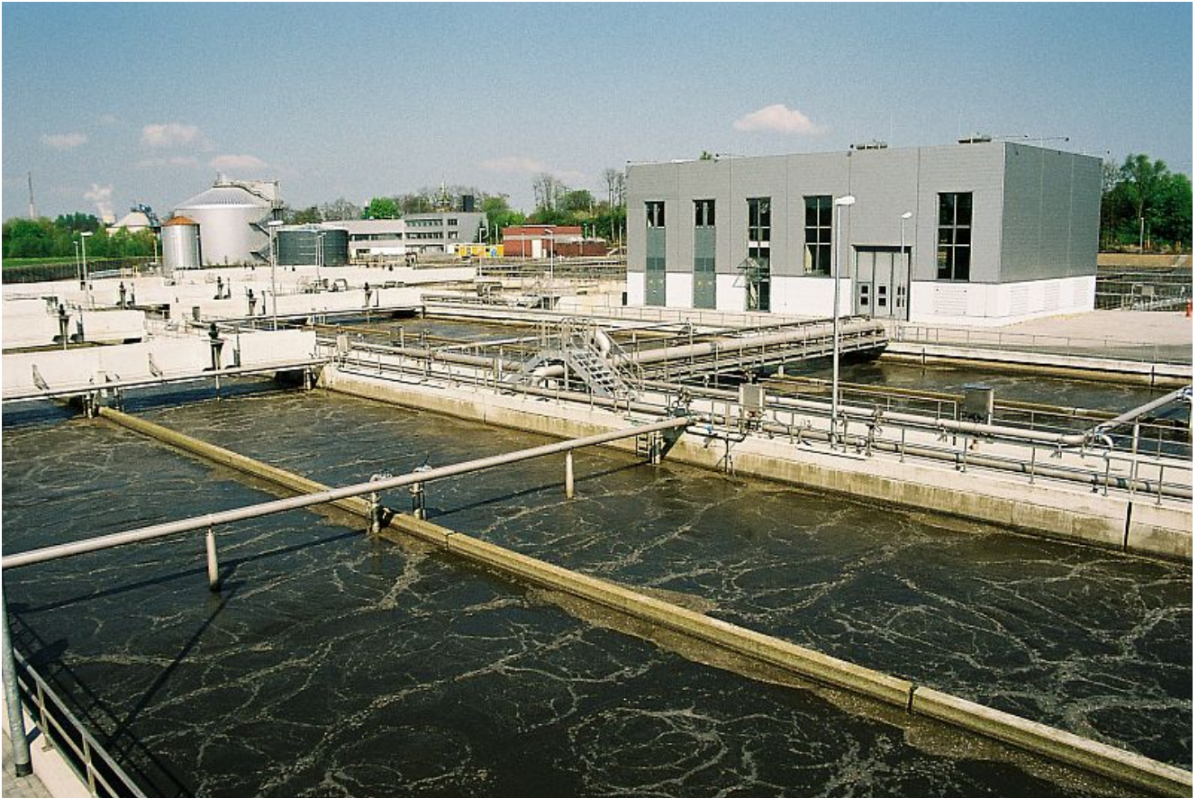
Kläranlage Lünen. Foto: Lippeverband
