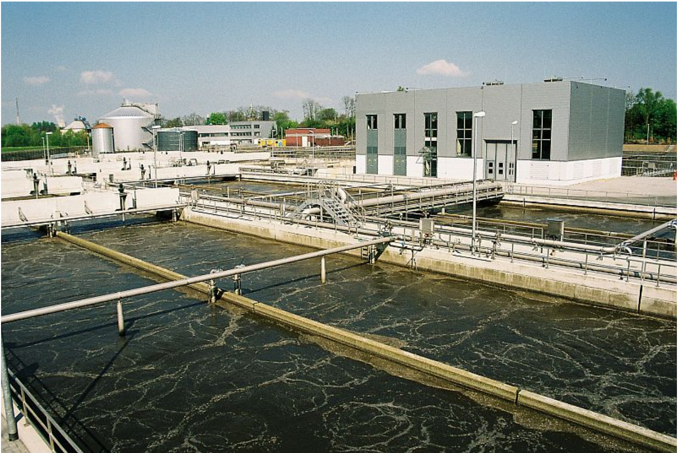
Kläranlage Lünen. Foto: Lippeverband
