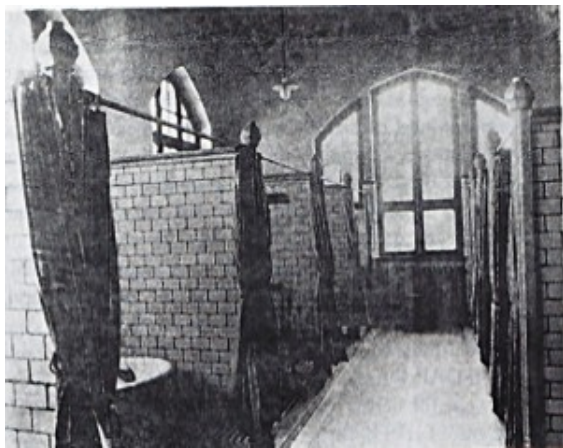
Waschkabinen im Wohlfahrtsgebäude
