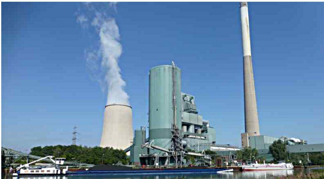
Das Steinkohlekraftwerk in Heil.
