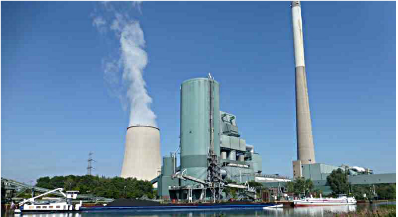
Das Steinkohlekraftwerk in Heil.
