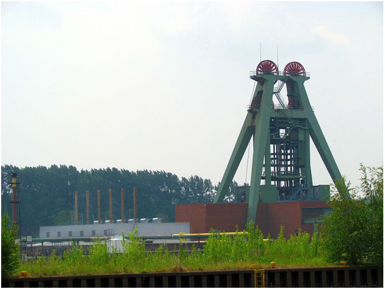
Das Schachtgerüst Haus Aden 2 .
