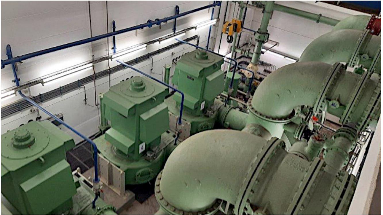
Pumpwerk Beverbach in Rünthe. Foto: Aktionskreis / Röcher
