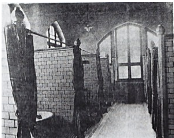
Waschkabinen im Wohlfahrtsgebäude
