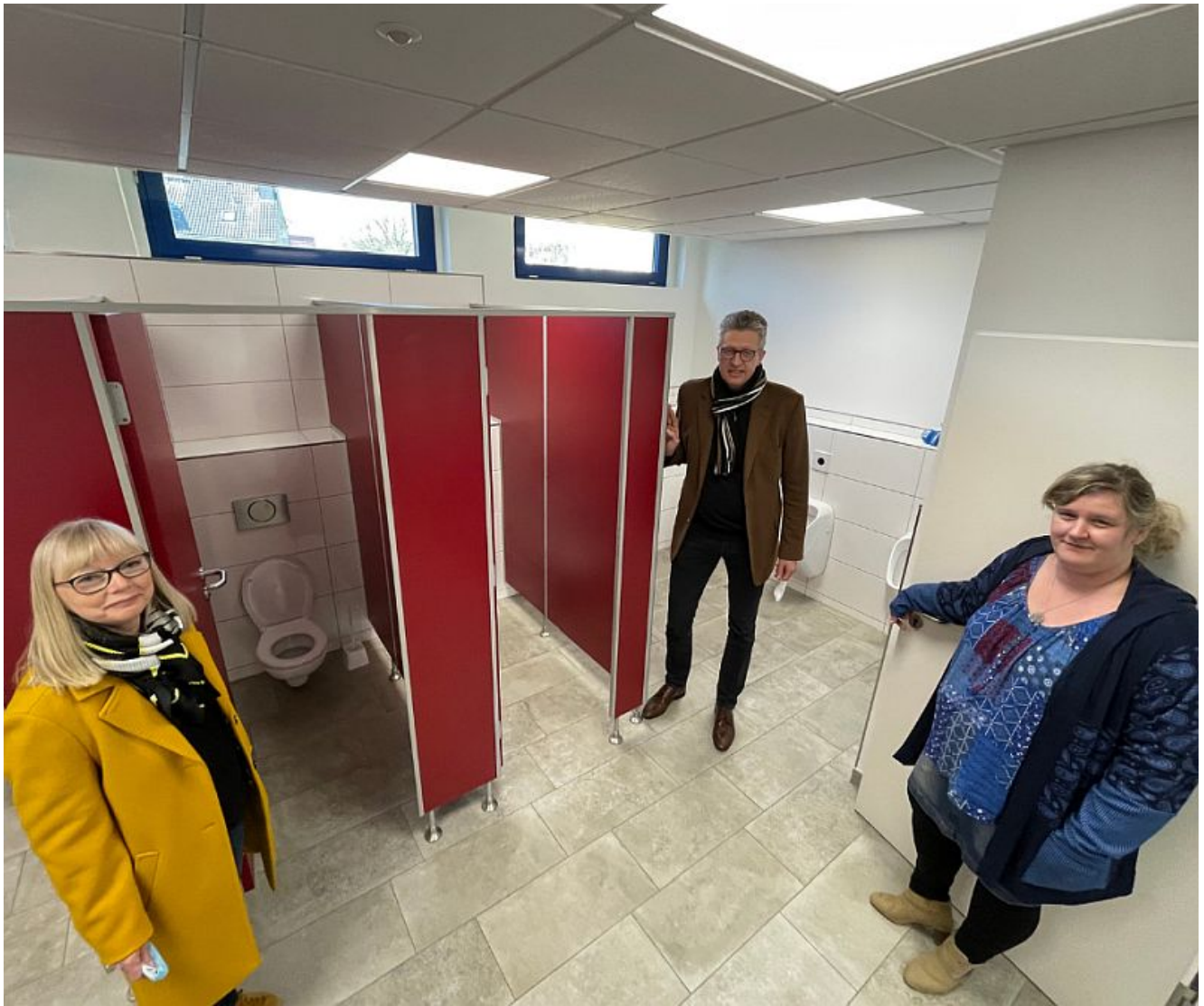
Begutachtet und für gut befunden: die sanierten Sanitärräume der Freiherr-von-Ketteler-Schule. Foto: Stadt Bergkamen
