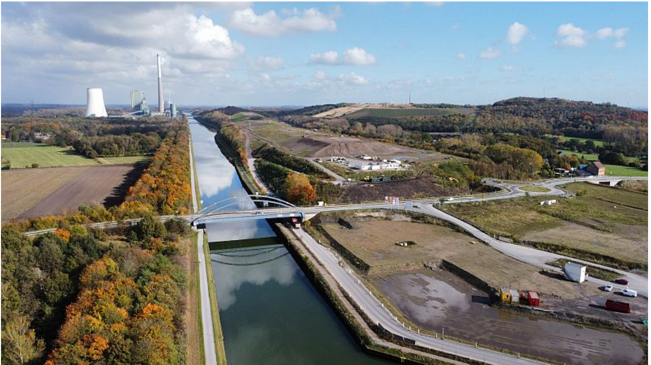
IGA-Baustelle auf dem Kanalband. Foto: Stadt Bergkamen
