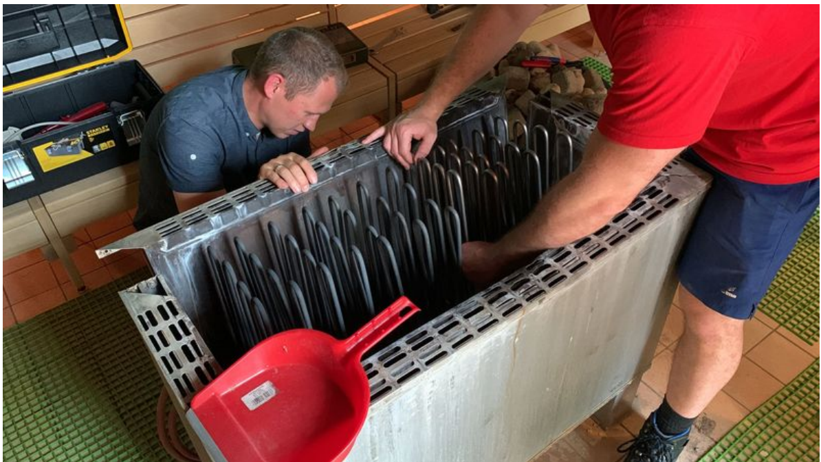
Die Heizstäbe im Saunaofen wurden während der Revisionsarbeiten erneuert. Foto: GSW
