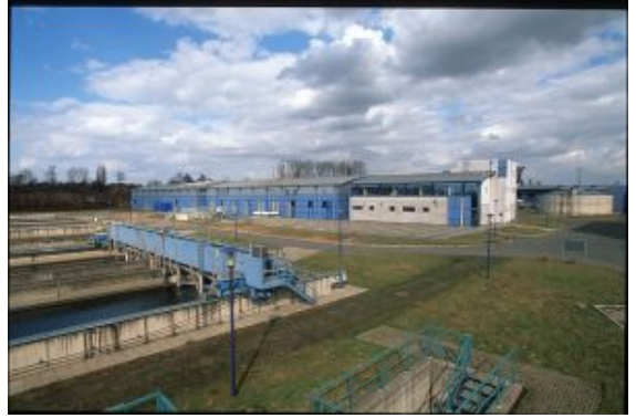
Die Kläranlage (KLG) Kamen-Körnebach.
