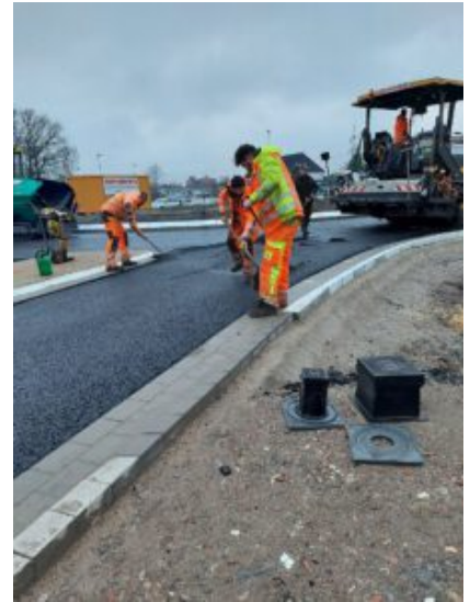
Asphaltarbeiten am nördlichen Kreisverkehr. Foto: Ludewig+Bock
