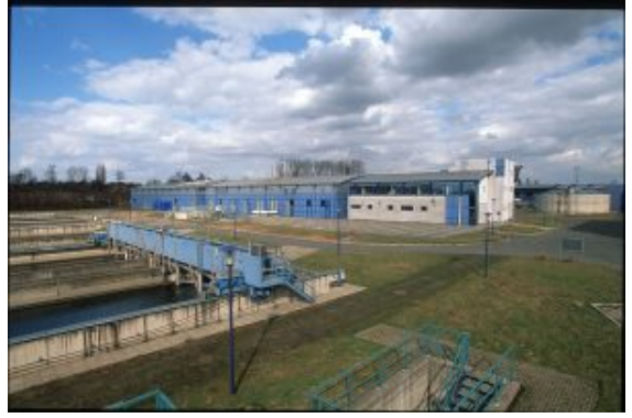
Die Kläranlage (KLG) Kamen-Körnebach.
