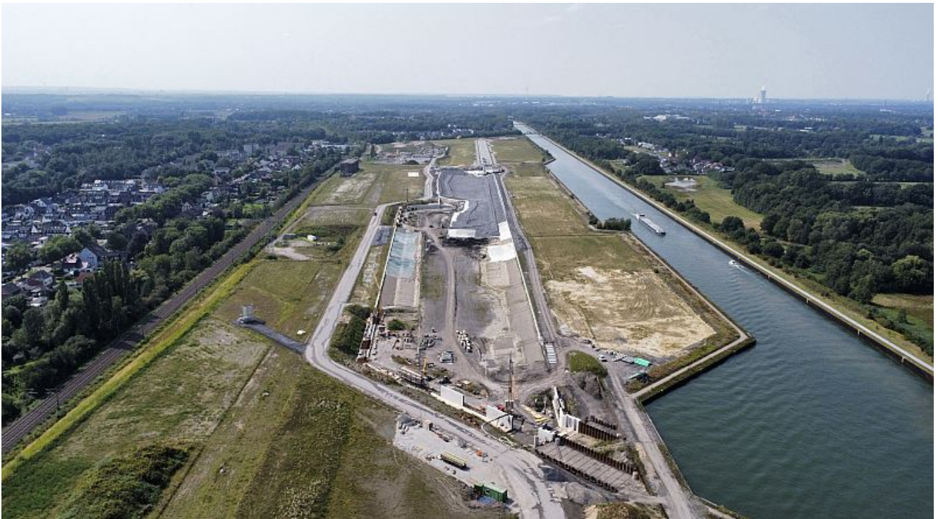
Großbaustelle Wasserstadt Aden.
