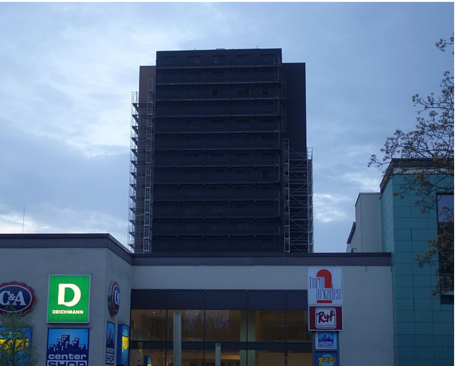
Bergkamener Wohnturm in der Abenddämmerung.
