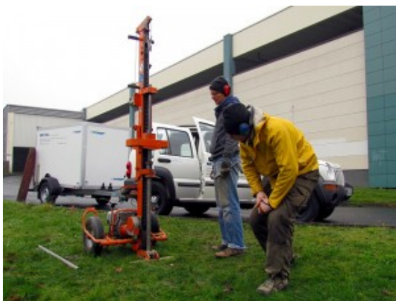
Baugrunduntersuchungen im Außenbereich der künftigen BergGalerie
