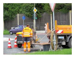
Im Einmündungsbereich der Geschwister-Scholl-Straße in die Landwehrstraße werden Induktionsschleifen eingebaut.
