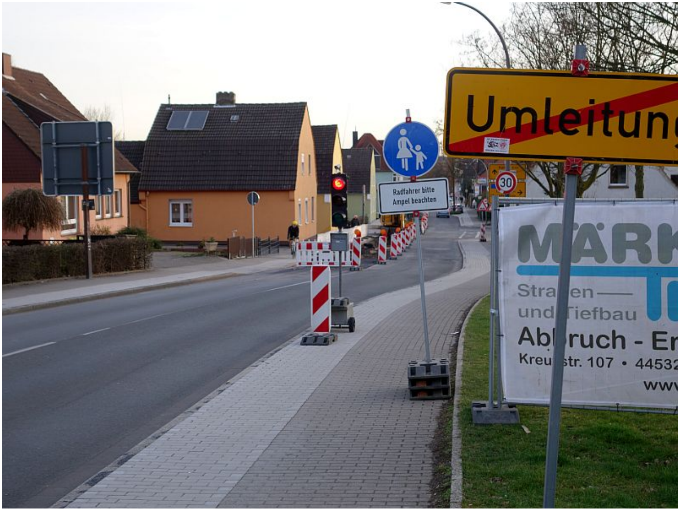
Baustelle auf der Töddinghauser Straße zwischen Schulstraße und Kreisverkehr.
