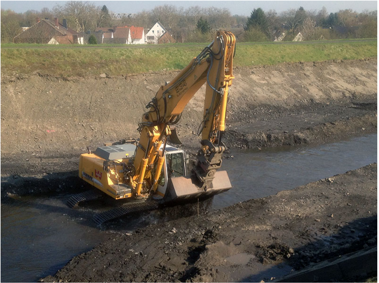
Bagger im Unterlauf der Seseke
