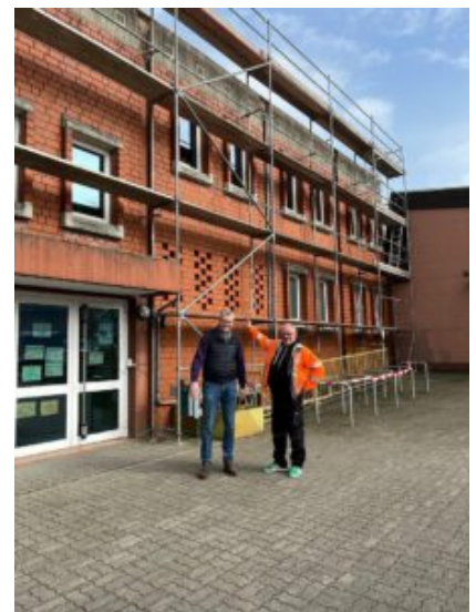
Bernd Schäfer (l.) mit dem Leiter des Baubetriebshofs Stephan Polplatz am
