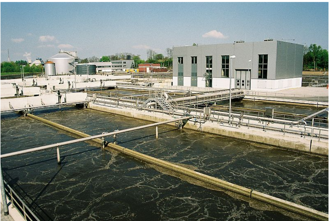
Kläranlage Lünen. Foto: Lippeverband
