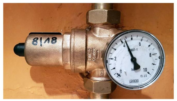
Druckminderventil mit Manometer.
