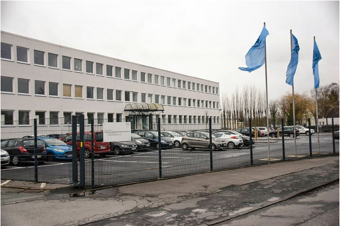
Das neue Dienstgebäude an der Zechenstraße 49. Foto: Max Rolke – Kreis Unna
