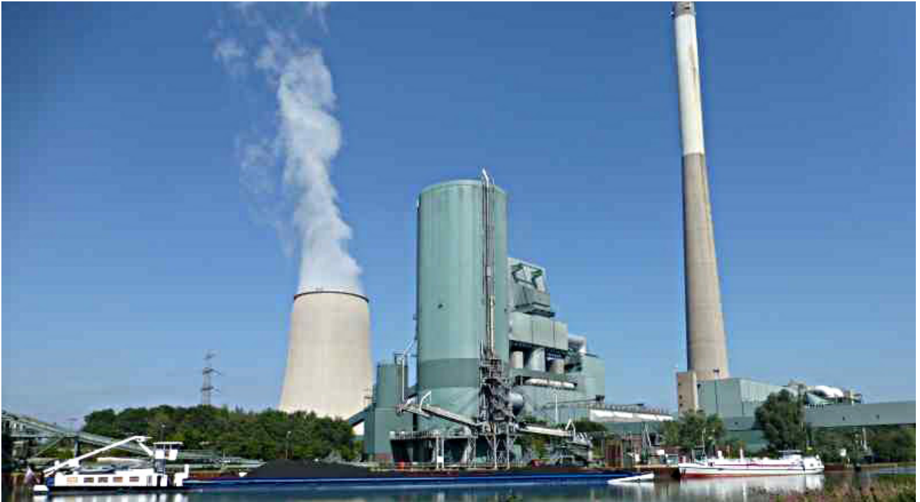
Das Steinkohlekraftwerk in Heil.
