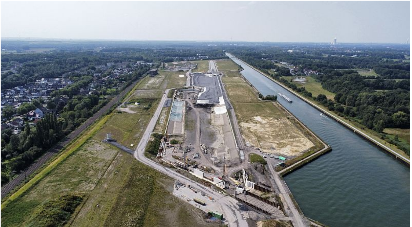
Großbaustelle Wasserstadt Aden.
