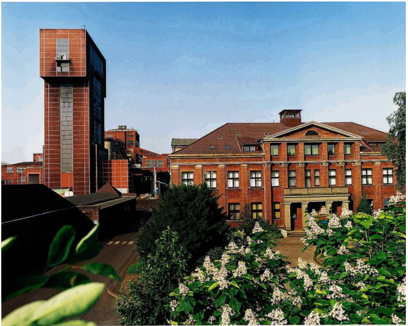
Ehemaliges Bergwerk Ost in Hamm
