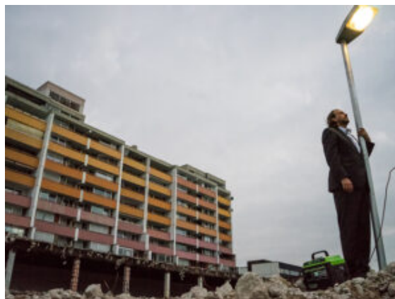
Fast schon historisch auf der City-Baustelle.
