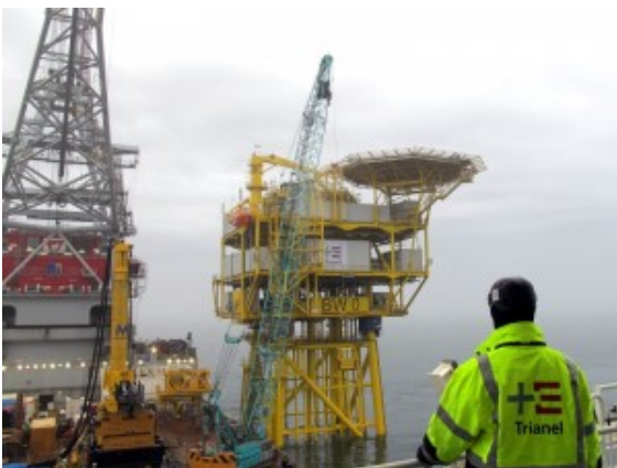
Bau der Umspannplattform
