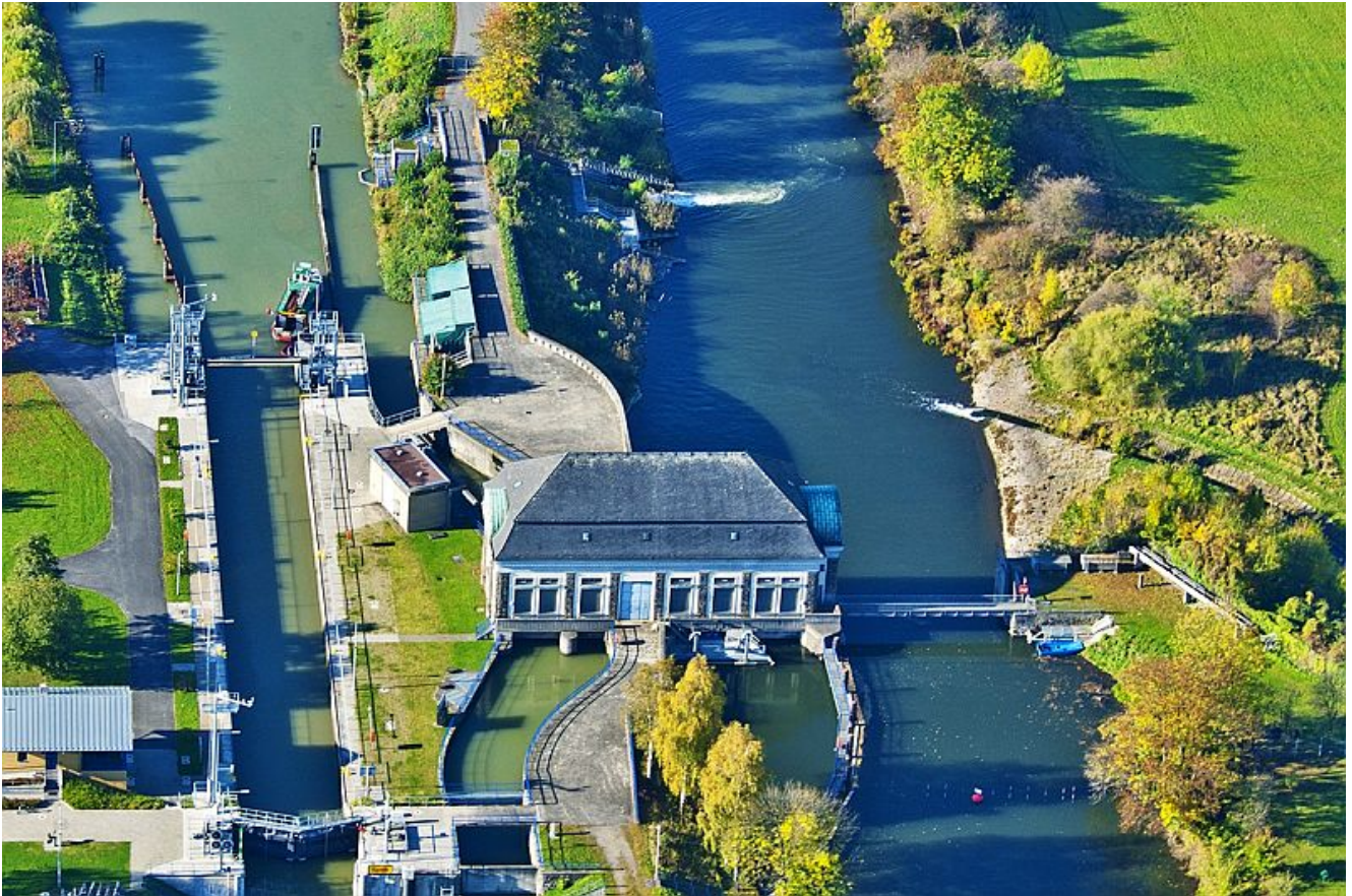
Überleitungsbauwerk in Hamm zwischen Lippe (rechts) und Kanal (links) an der Schleuse Hamm. Foto: Luftbild Hans Blossey
