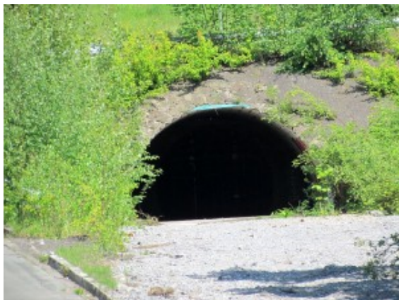
Der Eingang zu Tunnel in den Bergehalden. Nach etwa
