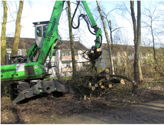
Der Sennebogen bei der Arbeit.
