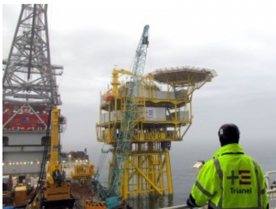
Bau der Umspannplattform
