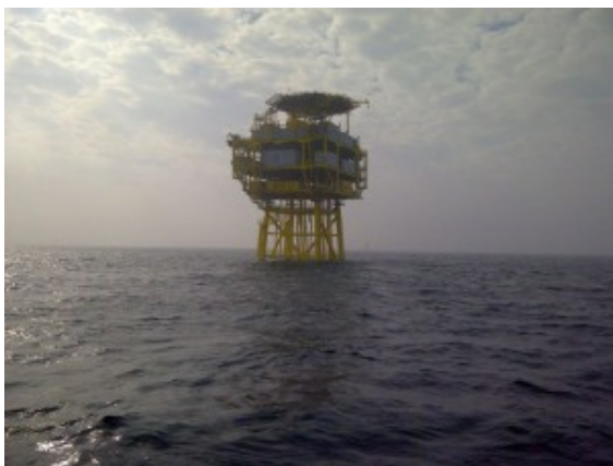
Die Umspannplattform in der Nordsee vor Borkum.
