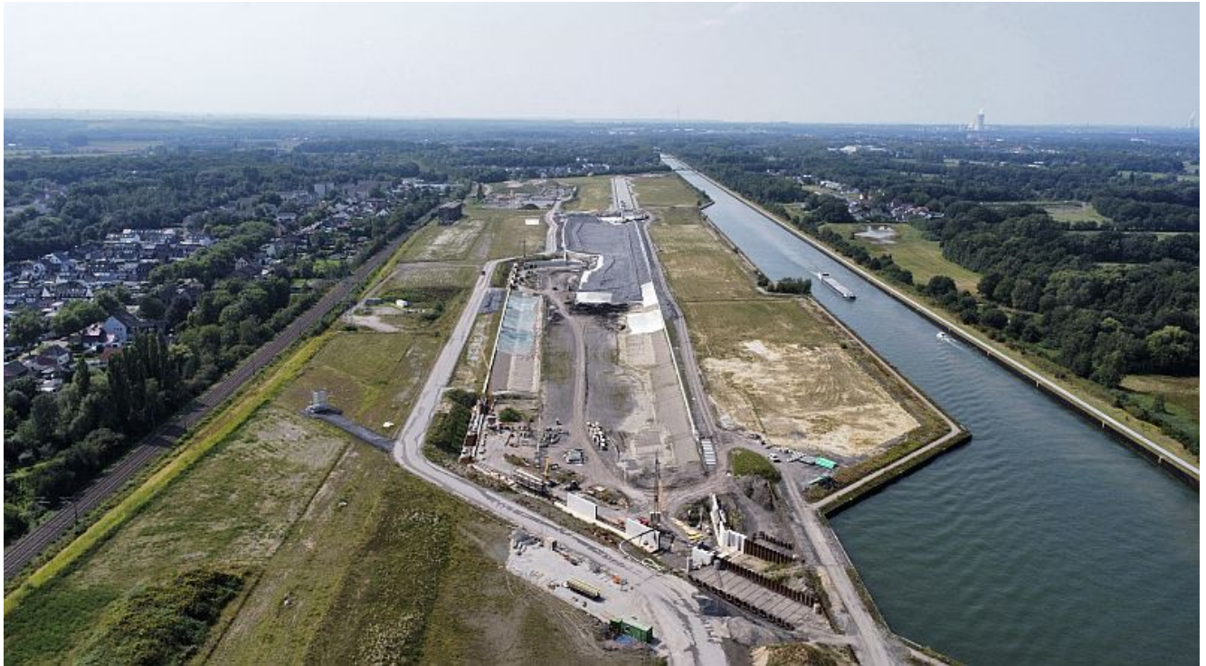
Großbaustelle Wasserstadt Aden.
