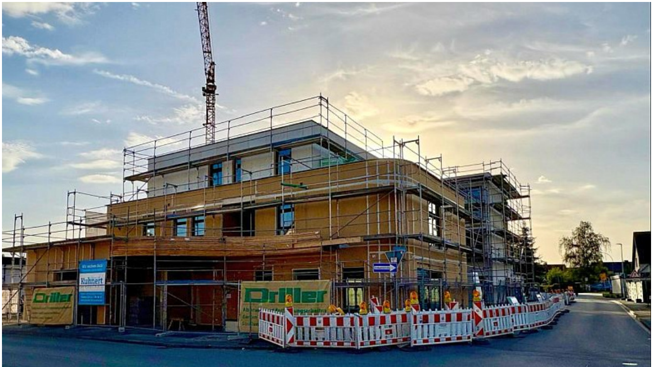
Neubau der Geschäftsstelle Oberaden. Foto: Sparkasse Bergkamen-Bönen
