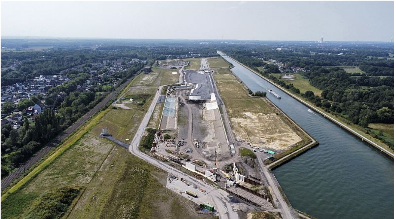
Großbaustelle Wasserstadt Aden.
