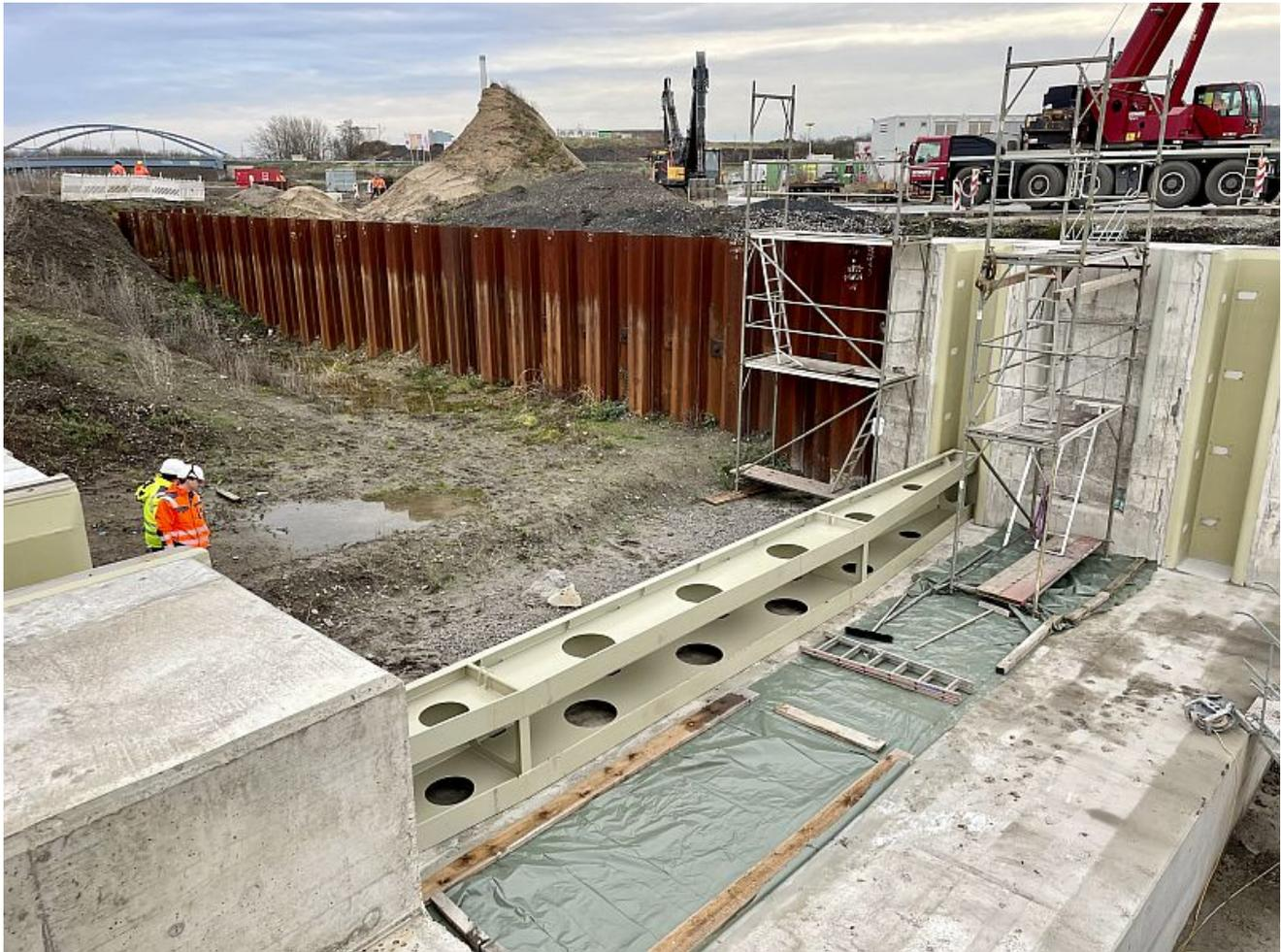
Die Wasserstadt Aden – das aktuell größte städtebauliche Projekt der Stadt Bergkamen – hat einen weiteren bedeutenden Meilenstein erreicht: *Am Donnerstag, 5. Dezember*, starten die Arbeiten am sogenannten Verschlussbauwerk. Diese Konstruktion ist ein zentrales Sicherheits- und Funktionselement, welches es ermöglicht, den in Bau befindlichen Adensee im Ernstfall – beispielsweise bei einer Havarie oder einem Leck – schnell und sicher vom Datteln-Hamm-Kanal zu trennen.
