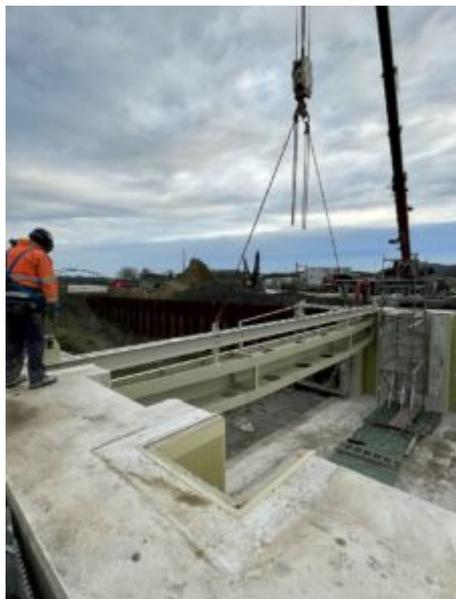
Das Verschlussbauwerk ist als U-förmige Betonkonstruktion mit seitlichen Führungsschienen gestaltet, in das die stählernen Dammbalken, mit einem Mobilkran von oben eingesetzt und aufeinandergestapelt werden. Dieser Arbeitsschritt markiert den Beginn der letzten Bauphase an der Ein- und Ausfahrt des Adensees. Nach dessen Fertigstellung wird dieser Bereich geflutet und später mit dem Kanal verbunden.
