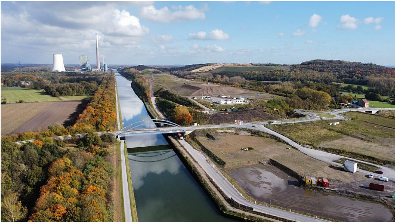
IGA-Baustelle auf dem Kanalband. Foto: Stadt Bergkamen
