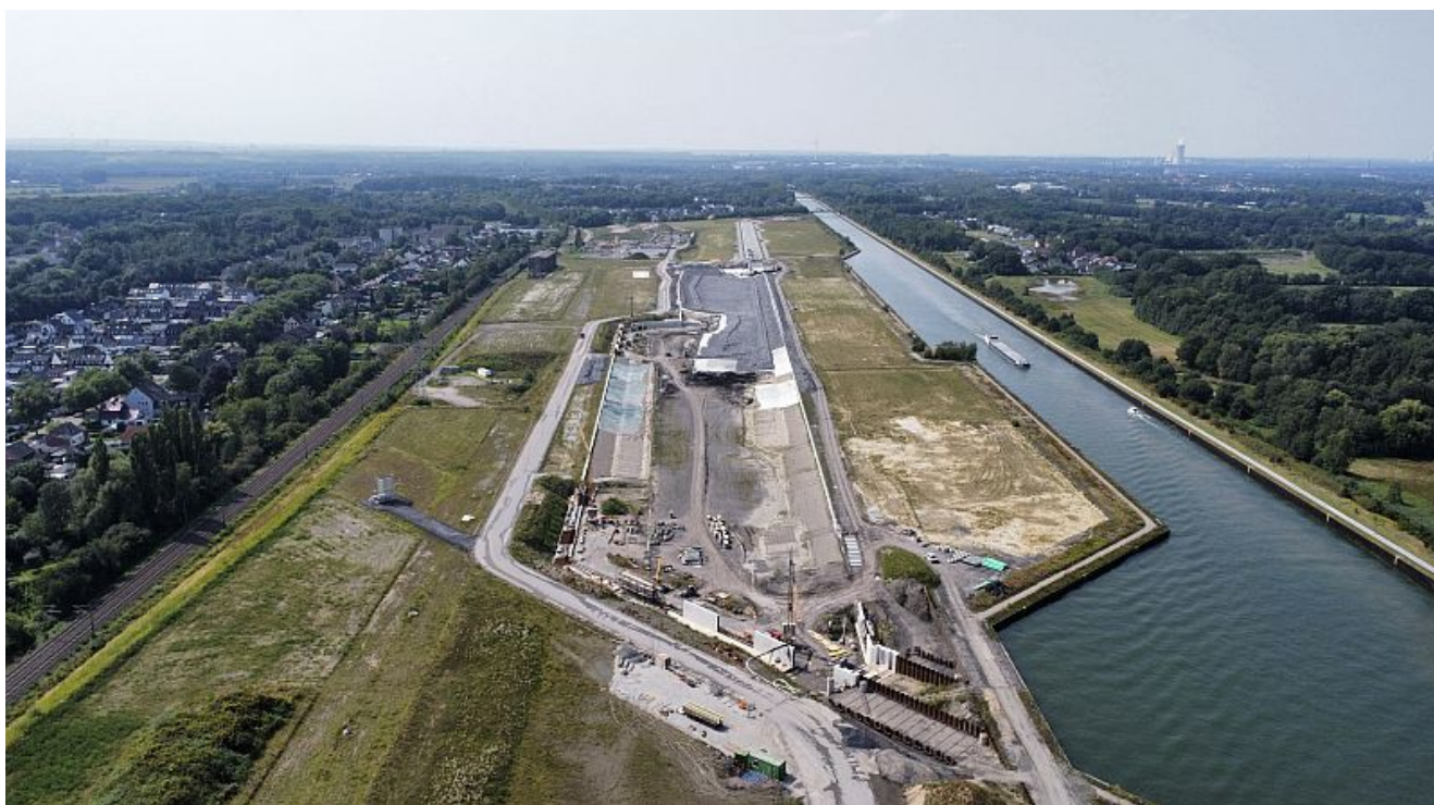
Großbaustelle Wasserstadt Aden.
