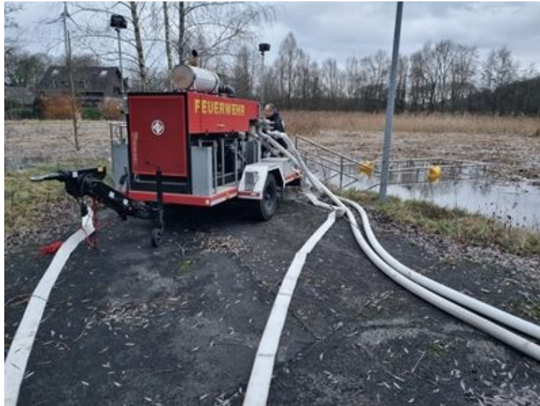
Hochwassereinsatz an der Overberger Straße. Foto: Feuerwehr
